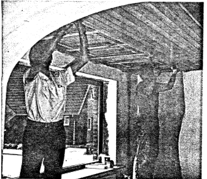
Abb. 48: (83/34/4) Deckenverkleidung montieren
