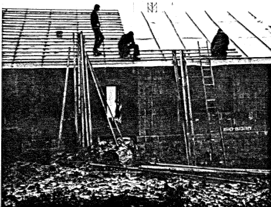
Abb.132: Selbsthilfeeinsatz beim Aufnageln der Dach- latten
