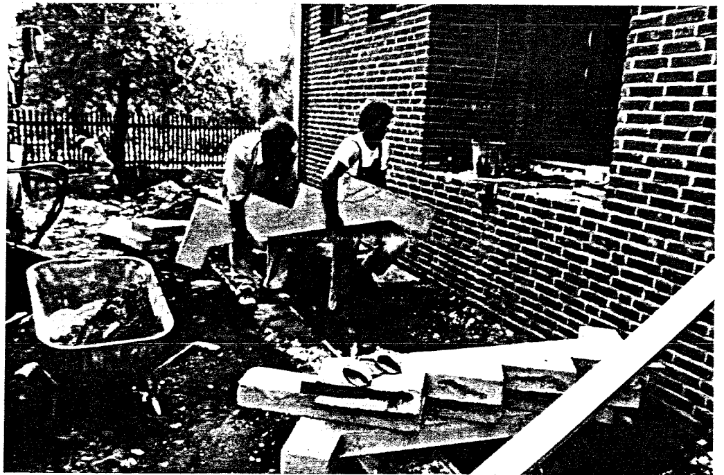
Abb. 122: (83/26/35) Montage der Treppe an der Gartenseite des Hauses.
