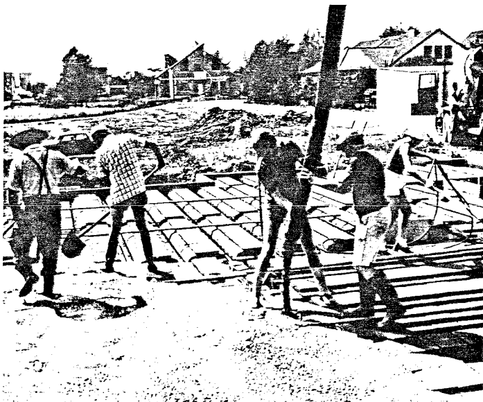
Abb. 61: (84/56/30) Hohlkörperdecke betonieren
