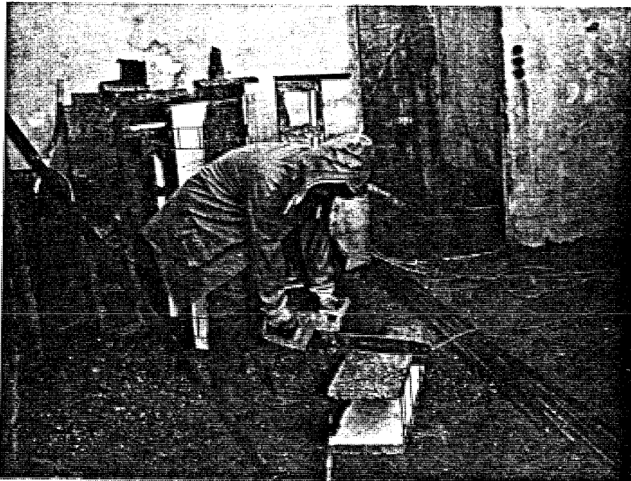
Abb.129: Zuschnitt eines Schalungs- steines mit der Motorsäge
