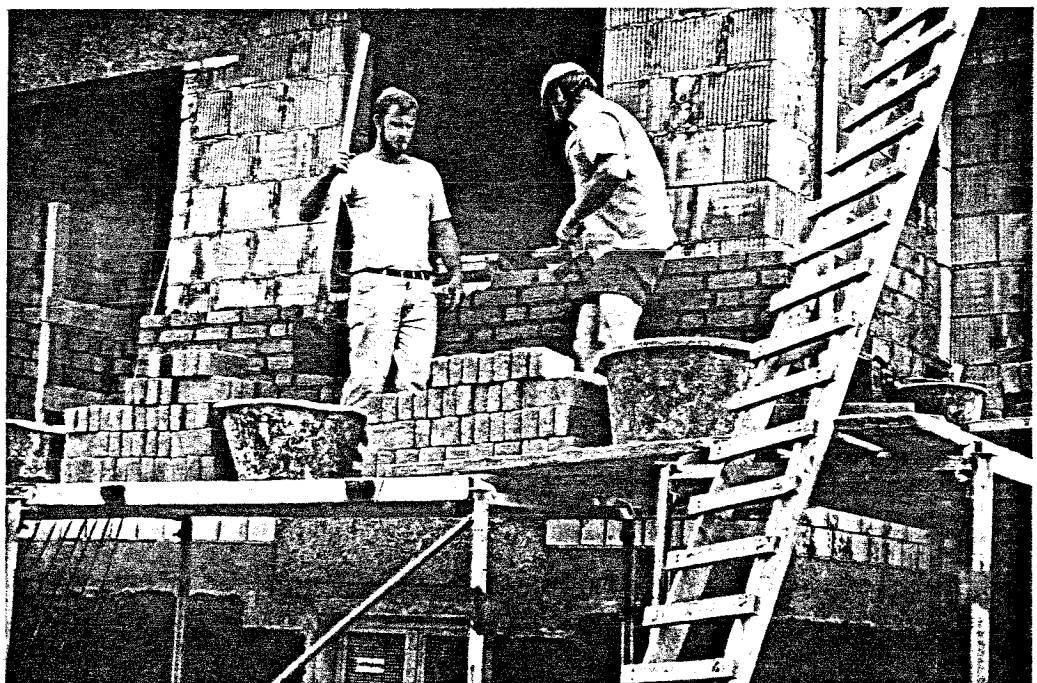
Abb. 15: (84/43/1 ) Herstellen des Verblendmauerwer- kes
