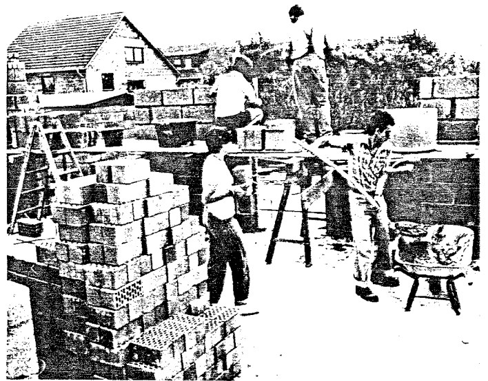
Abb. 60: (84/56/32) Herstellen des Mauermörtels
