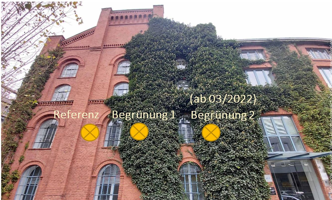
Abb. 10: Platzierung der Sensoren für die Messungen des U-Werts am Standort Muthgasse 109
