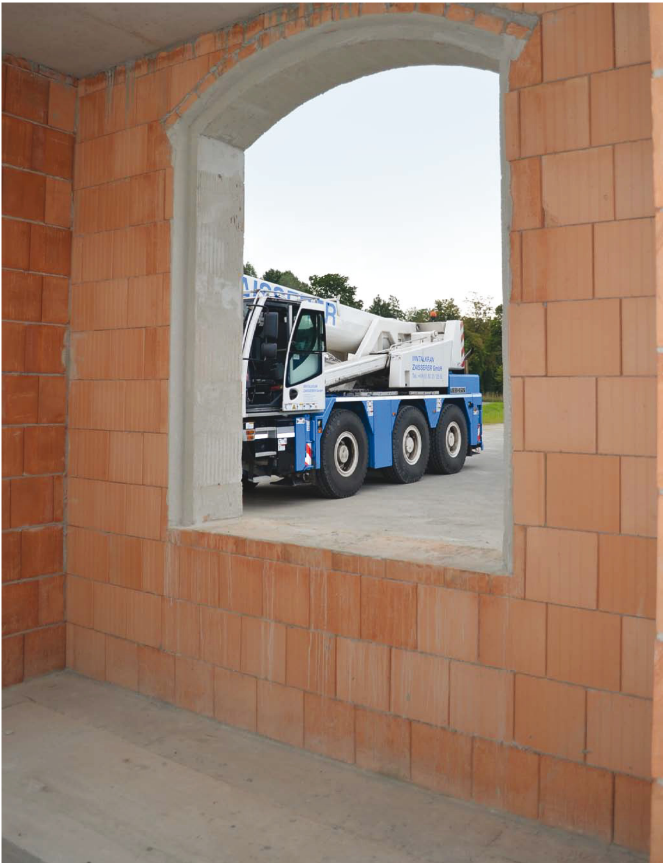
Innerer Anschlag für Fenster mit aufgebrachtem Putz-Glattstrich
