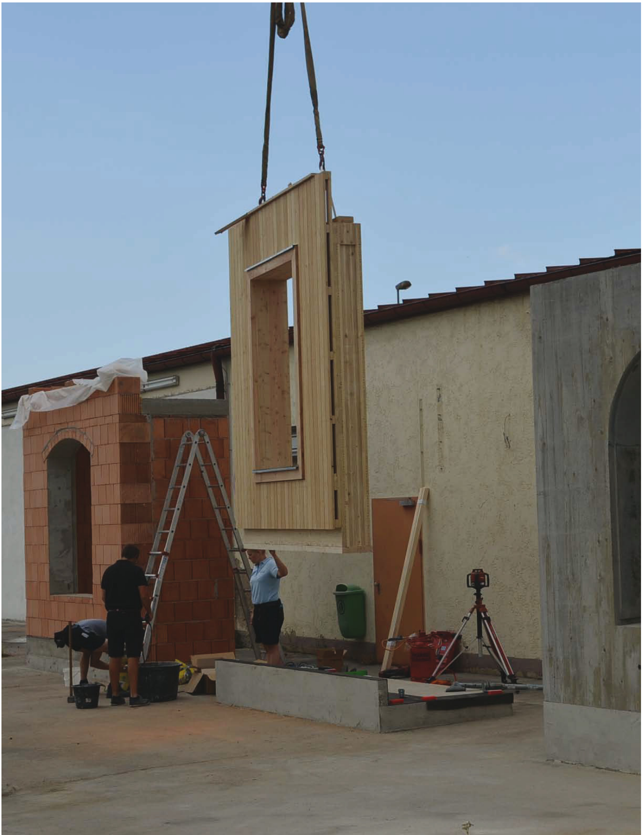
Montage der Außenwand aus Massivholz mit Außenverschalung
