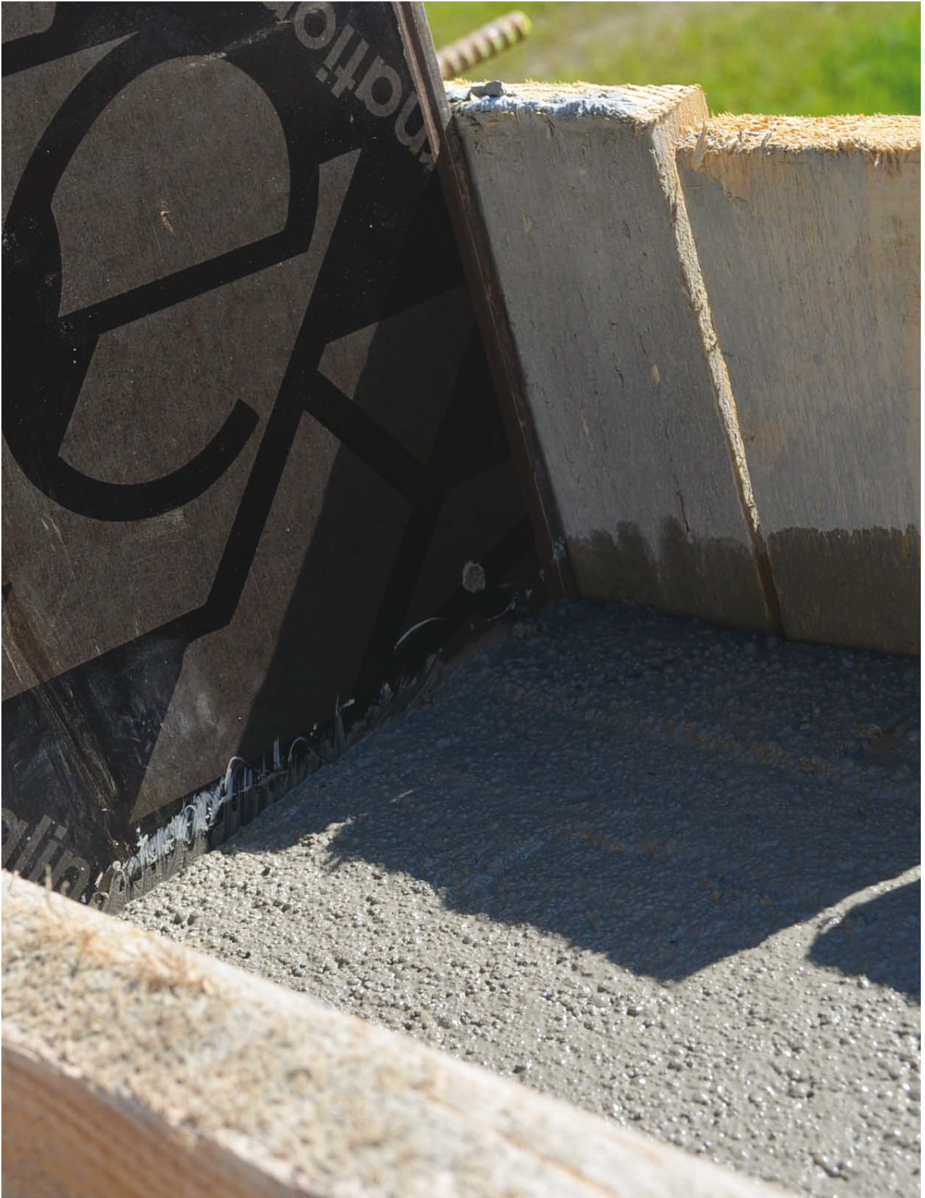
Oberkante der Wand zum Ende des Betoniervorgangs
