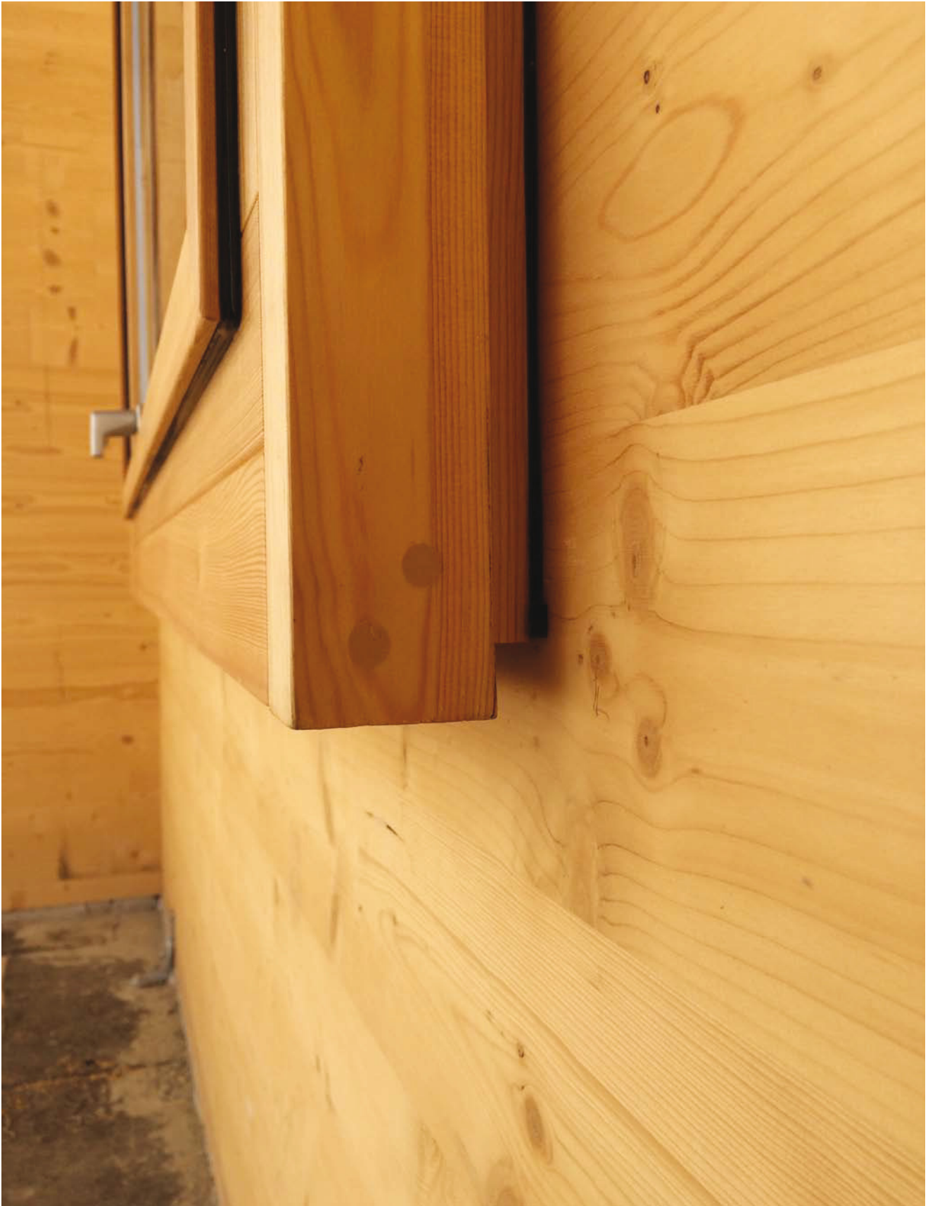
Fenster auf Innenseite der Holzmassivwand aufgesetzt und mit Quellbändern abgedichtet
