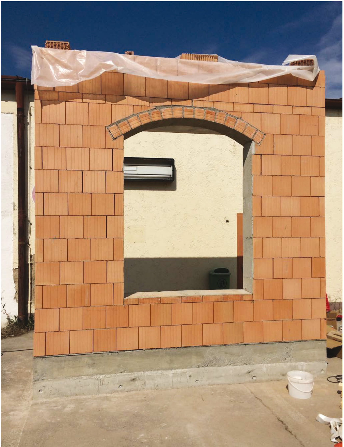
Fensteröffnung mit Segmentboden aus geviertelten Außenwandsteinen
