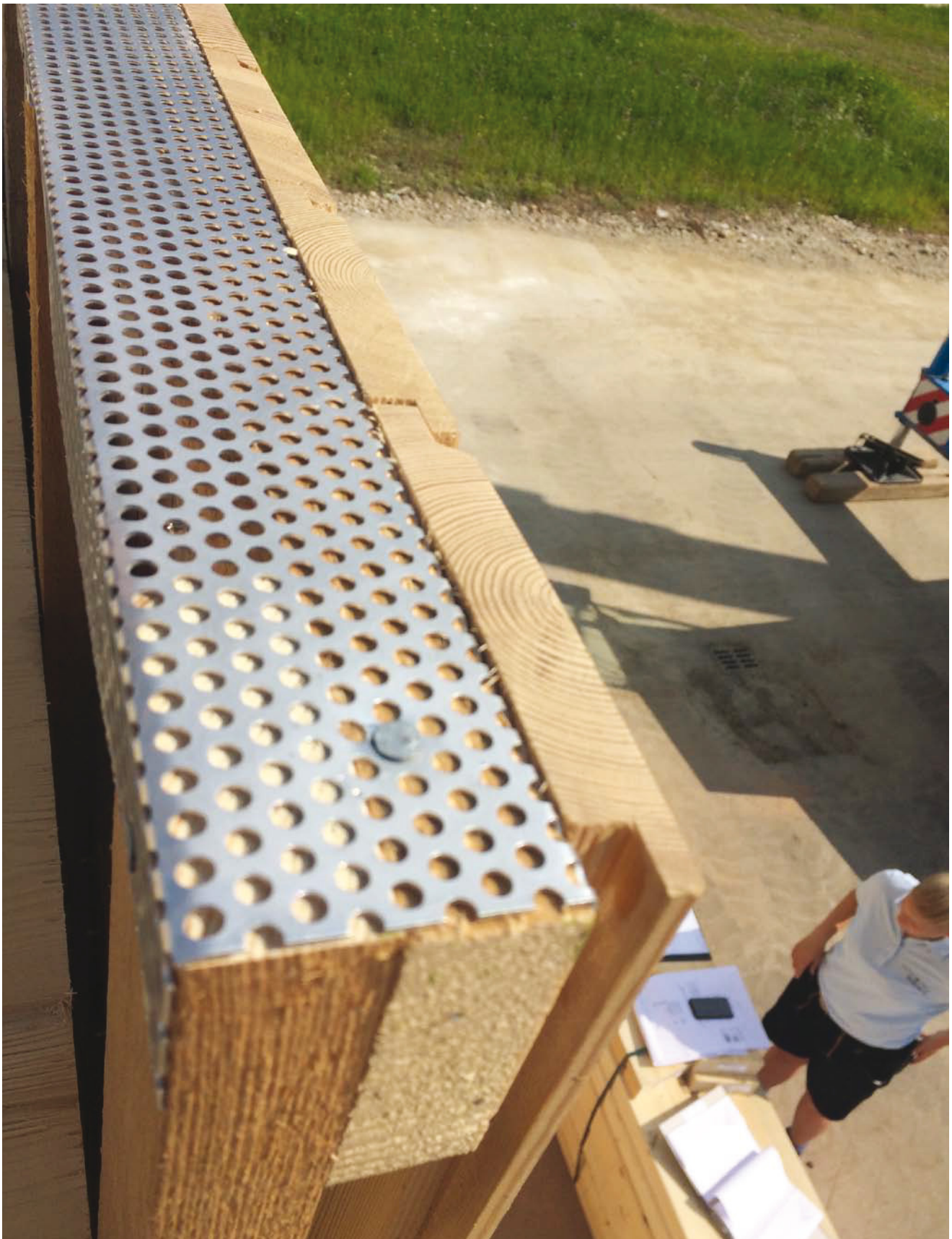
Lüftungsgitter und sägeraue Außenverschalung mit Falzen
