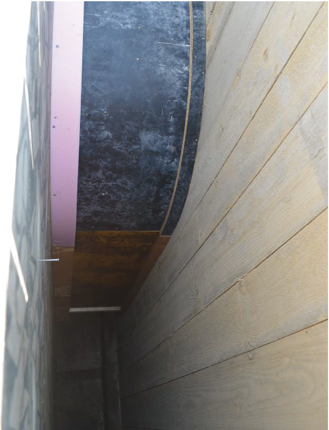
Schalung vor dem Betonieren, sägerauhe Bretter mit Zementleim vorgestrichen
