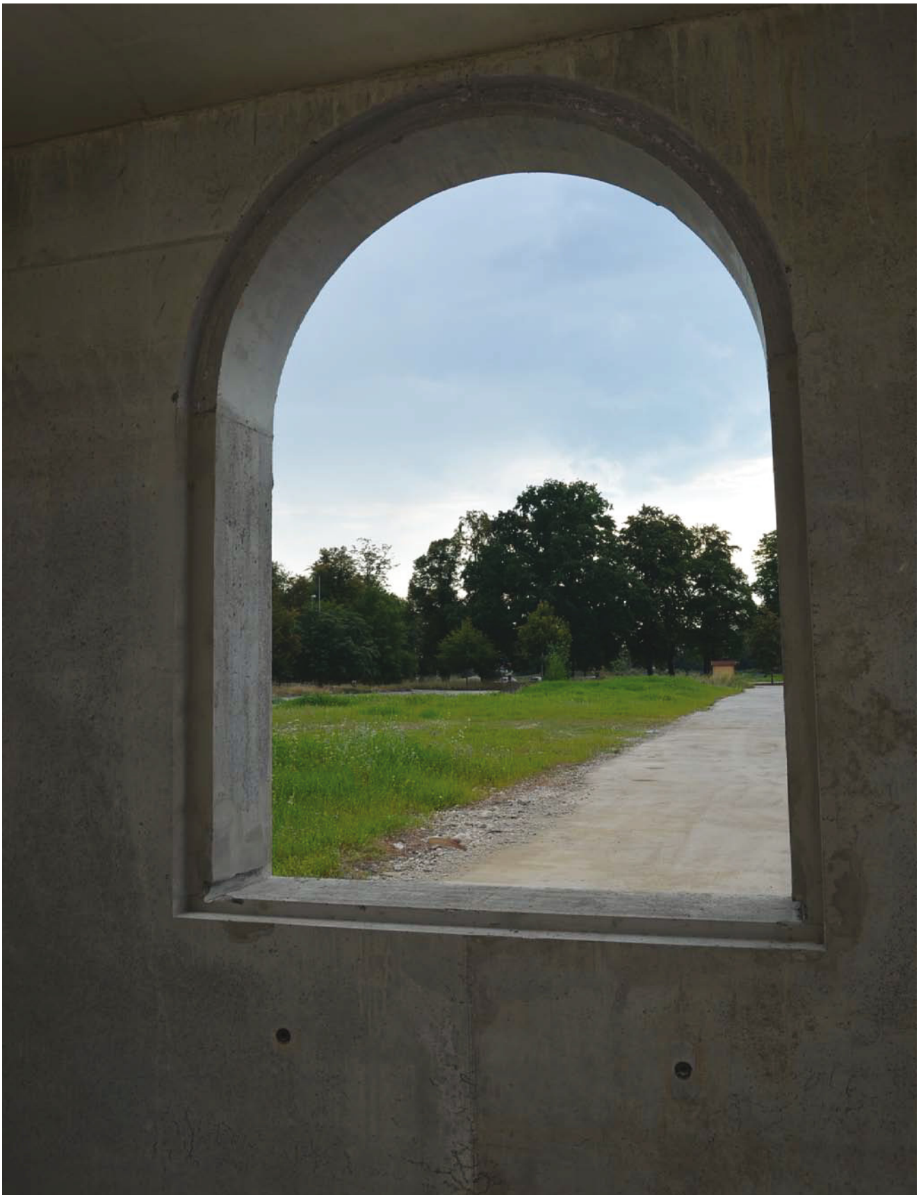
Innenseite der Betonwand nach dem Ausschalen
