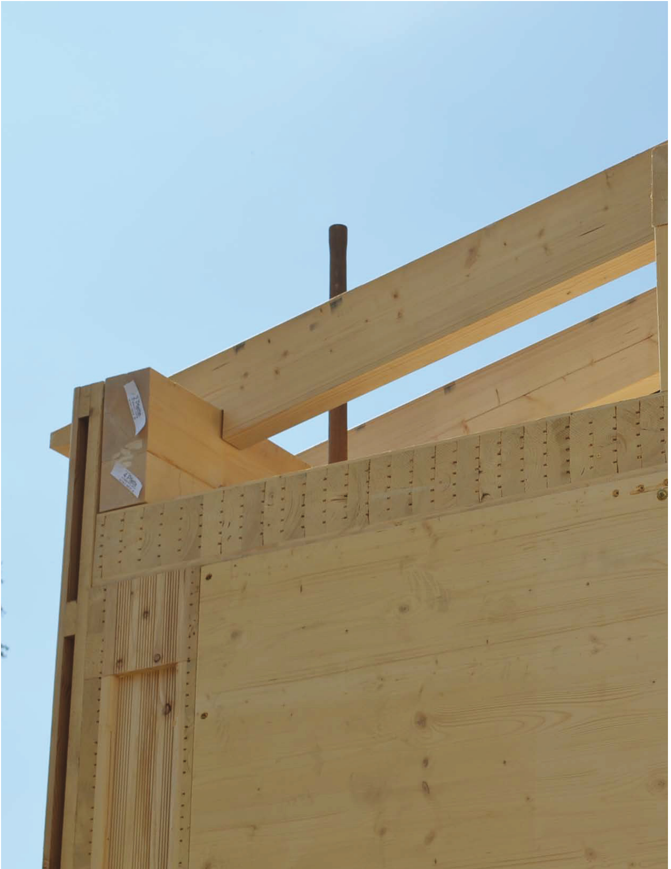
Außenwand, Trennwand, Decke und Dachstuhl
