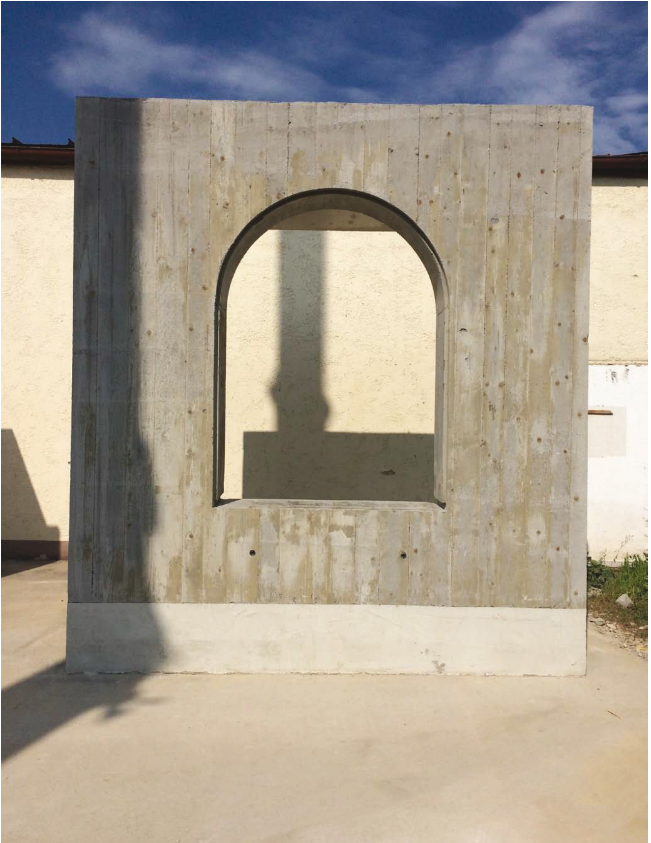
Außenseite der Betonwand nach dem Ausschalen
