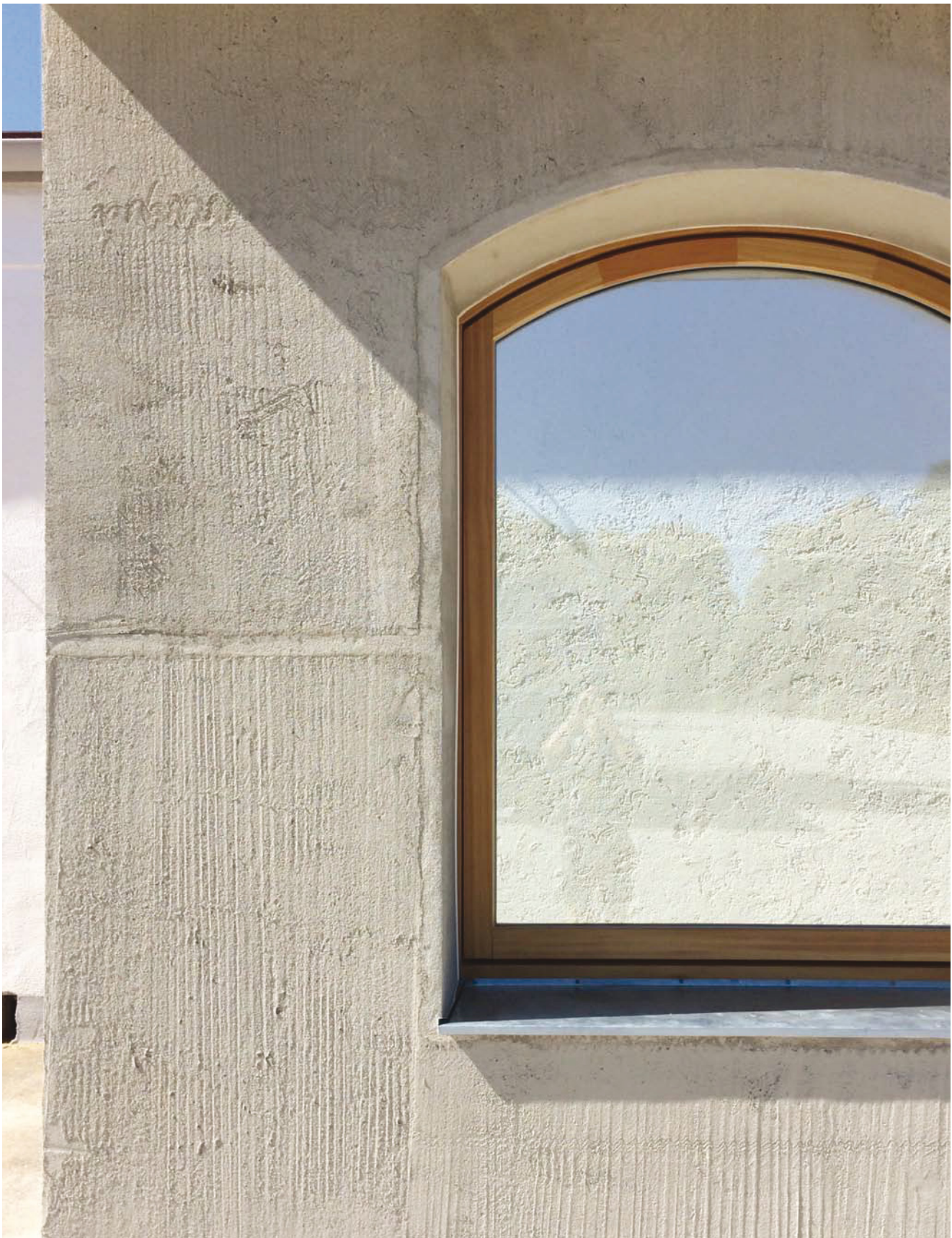
Außenwand Mauerwerk mit aufgebracht Putzschicht
