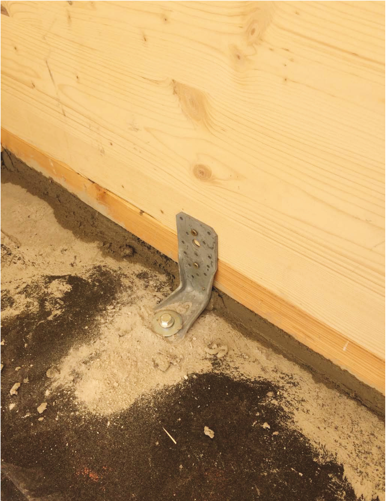
Ausmörteln der Lagerfuge
