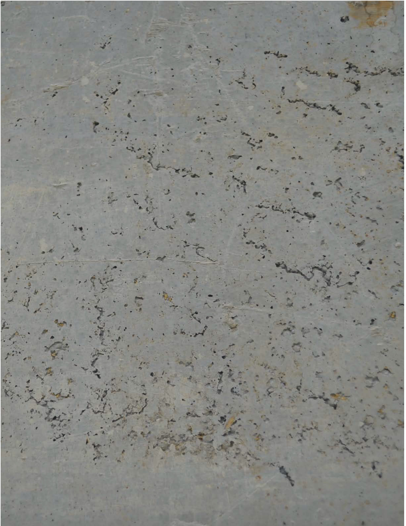
Die Innenseite mit glatter Schalung zeigt die, für Infraleichtbeton typische Oberflächenstruktur
