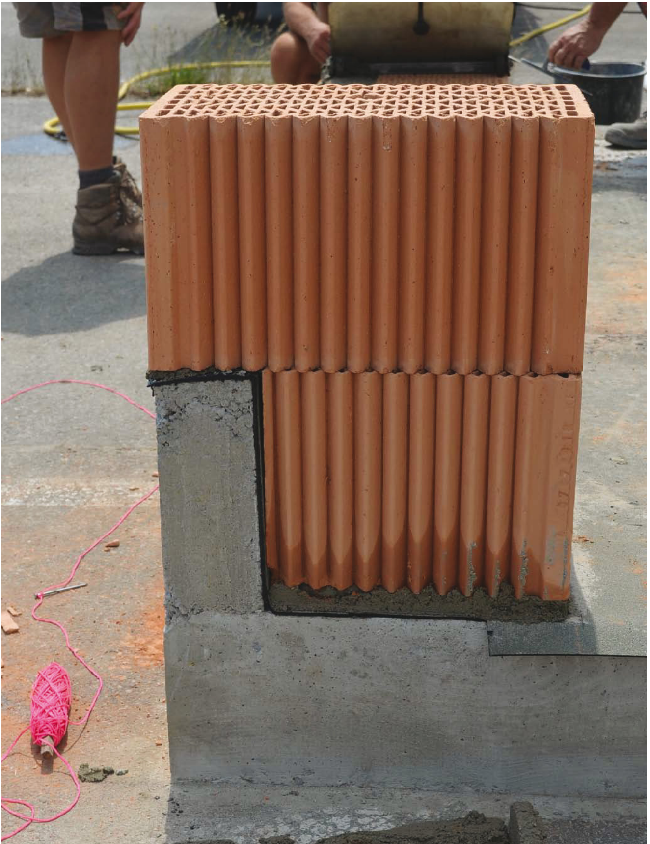
Fusspunkt Mauerwerk
