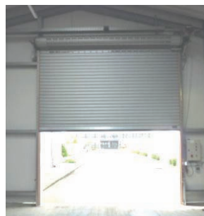
Abb. 5: Lamellen-Rolltor
