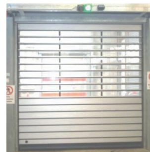
Abb. 6: Schnellaufspiraltor
