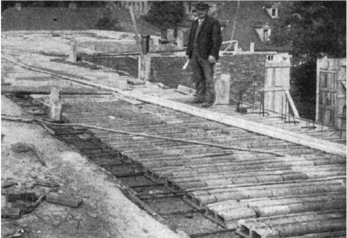
Abb. 5-1: Reformhohlsteindecke vor dem Betonieren, aus [Voormann - 2005]
