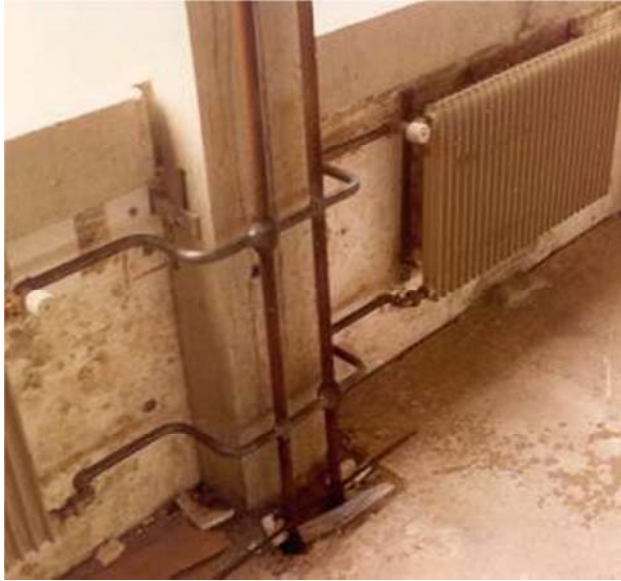
Abb. 3-3: Aus dem Fotoalbum des Bauherrn: Lage und Ausführung der Fassadenbefestigung
