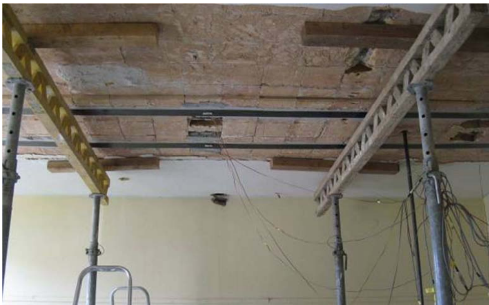
Abb. 3-25: Fertig montierte Lamellen mit DMS
