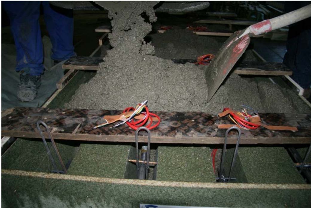
Abb. 5-7: Betonage des Versuchskörpers A-I
