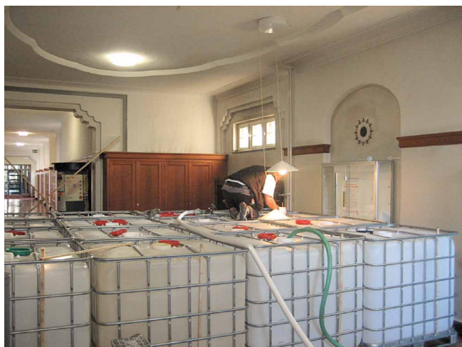
Zur Überprüfung der Tragfähigkeit der Decken wurden Wassertanks schrittweise bis zum Nachweis der geforderten Werte befüllt. (Fotograf: Reiner Jensen)
