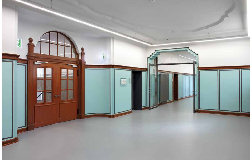
Eingangsfoyer mit Blick in Richtung des Flurs durch die neue Rauchschutztür mit der wiederhergestellten Farbfassung der aufgemalten Rahmen (Fotograf: Fotostudio Leniger)
