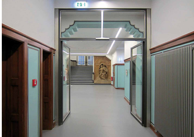
Blick vom Flur durch die neue Rauchschutztür in der Eingangsebene auf den Treppenaufgang und die Kniebe Skulptur (Fotograf: Reiner Jensen)
