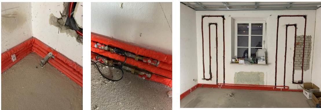
Abbildung 76: Tauchhülsen für Temperatursensoren; Volumenstromsensoren; Gesamtansicht nach Leitungsinstallation vor Verputzen
