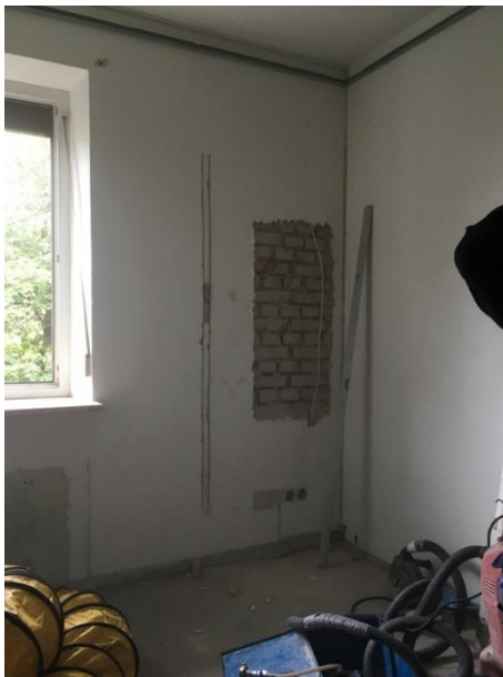
Abbildung 65: Testschlitz nach Mauernutfräse
