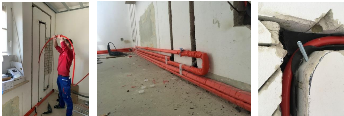
Abbildung 75: Einlegen des Rehau Rautherm-S Rohres; Einlegen des Rehau Rautherm-S Rohres; Fixierung der Rohrbögen
