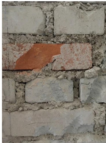
Abbildung 67: Freigelegtes Mauerwerk, Außenwand, bestehend aus Ziegel und Kalksandstein
