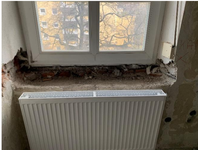
Abbildung 77: Schlafzimmer; Fenster; Heizkörper
