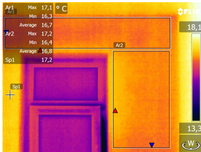
Abbildung 48: Thermografie Messstelle T4 Außenwand West/ Küche, Zeitpunkt 10.05.2019 um 09:29 Uhr
