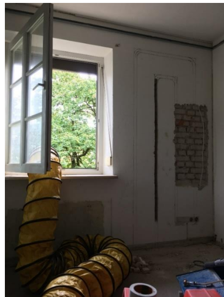
Abbildung 66: Testschlitz nach Stemmen
