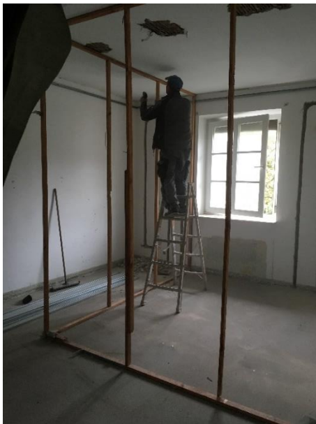
Abbildung 73: Abbau der Staubschutzwand
