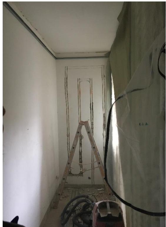
Abbildung 69: Schlitz nach Mauernutfräse
