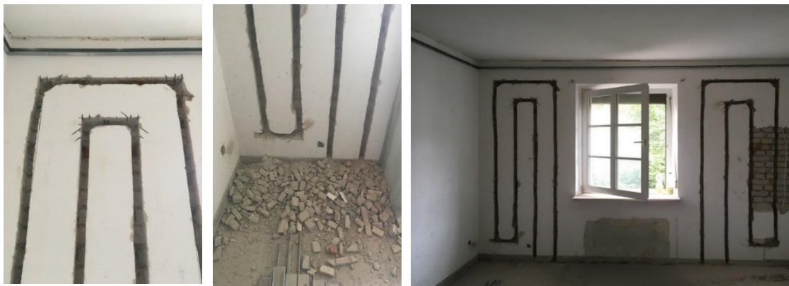
Abbildung 117: Detailaufnahme Schlitz; Entstehender Abfall (Schutt); Gesamtansicht Wohnzimmer-Außenwand mit Schlitzen
