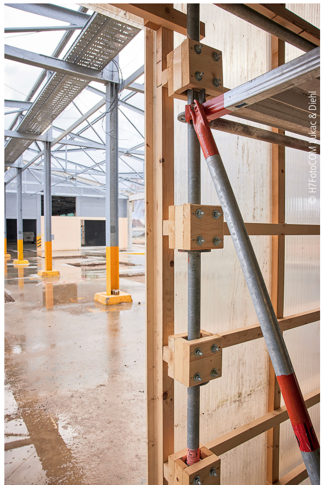
Abb. 11: Lösbare Verbindungen
