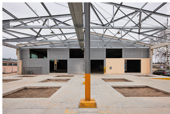
Abb. 10: Öffnung bestehender Brandwände
