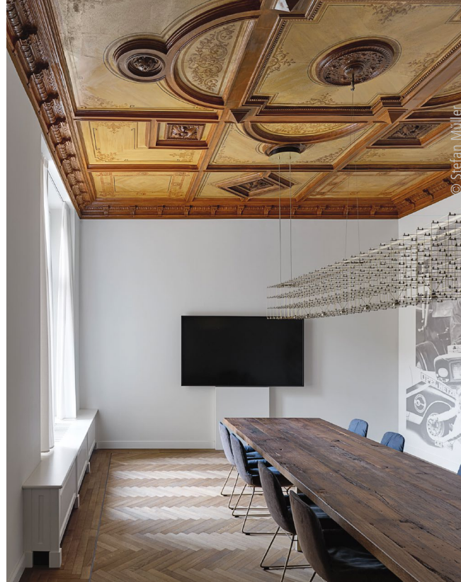
Abb. 5: Im Büroraum wurde bei der Instandsetzung und Modernisierung die Decke erhalten und restauratorisch überarbeitet.
