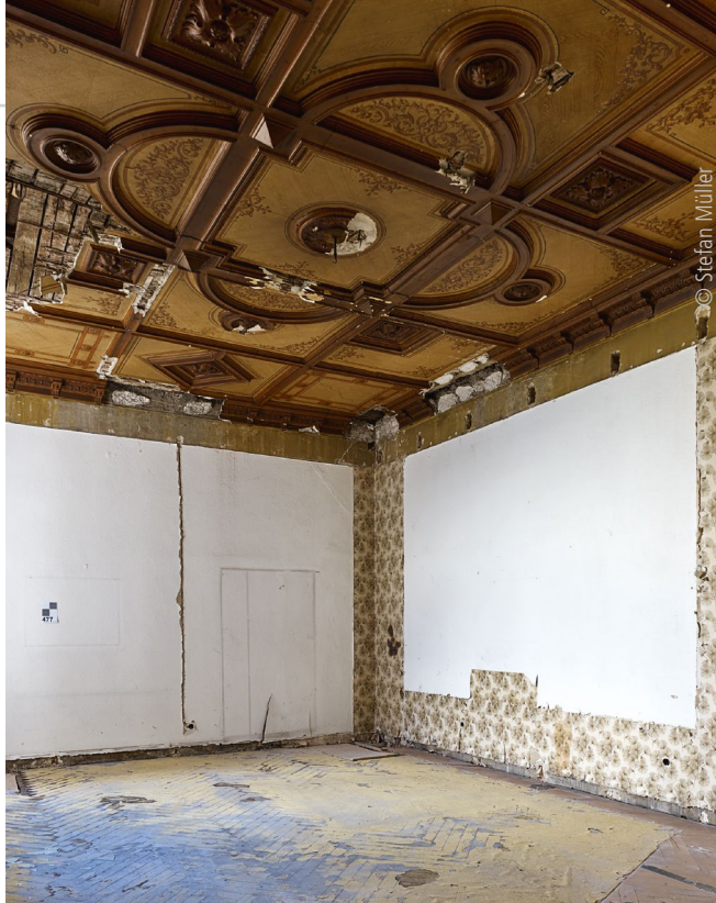
Abb. 5: Im Büroraum wurde bei der Instandsetzung und Modernisierung die Decke erhalten und restauratorisch überarbeitet.
