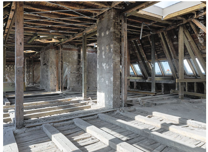
Abb. 3: Holzbalkendeckenkonstruktion während der Instandsetzung
