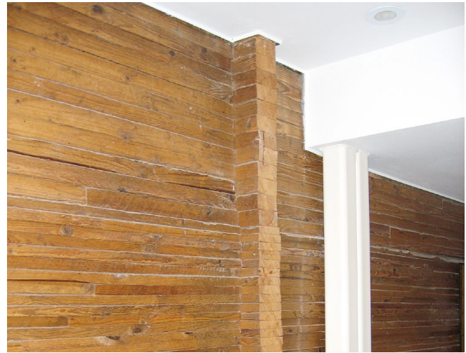
Abb. 3: Massivholzwand in einem Hotelgebäude
