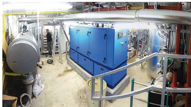
Abb. 9: Unter der Erde fand die neue Haustechnik mit dem Prototypen der Gasmotor-Wärmepumpe, dem Gas-Brennwertkessel und den insgesamt 12 m<sup>3</sup> fassenden Speichern Platz. (Foto: Architekturbüro Stocker)
