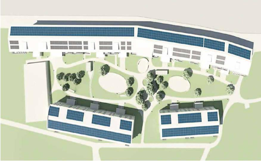
Abb. 3: Nach der Sanierung und Aufstockung liegen auf den beiden Nord-Süd-orientierten Gebäudezeilen PV-Module und Vakuum-Röhrenkollektoren. (Foto: Architekturbüro Stocker)
