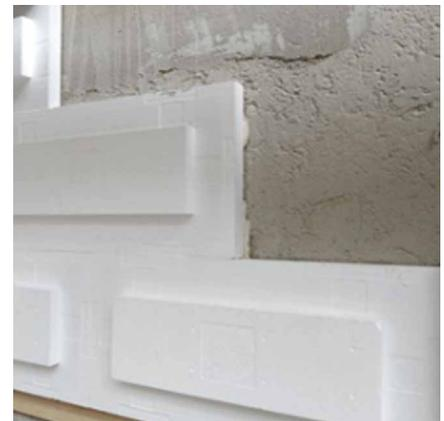
Abb. 6: Die empfindliche Vakuumdämmung ist durch Phenolharzschaum geschützt und wurde in zwei Schichten überlappend angebracht. (Foto: Architekturbüro Stocker)
