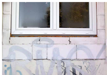
Abb. 7: Abdichtung eines Fensters durch Montageschaum
