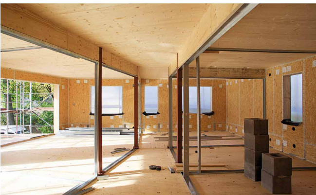
Abb. 3: Obergeschoss im Bauzustand
