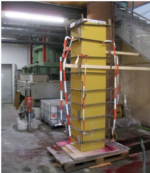
b) Schalkörper vor der Betonage (2,5 m x 0,4 m x 0,4) m
