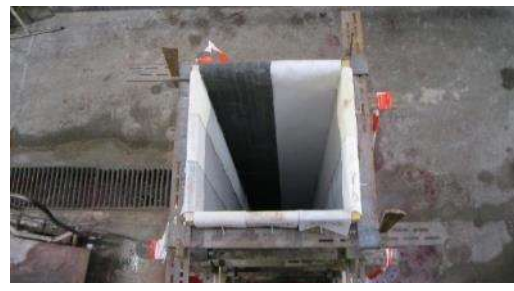
a) Blick in die Schalung mit den eingebauten FBV-Bahnen
