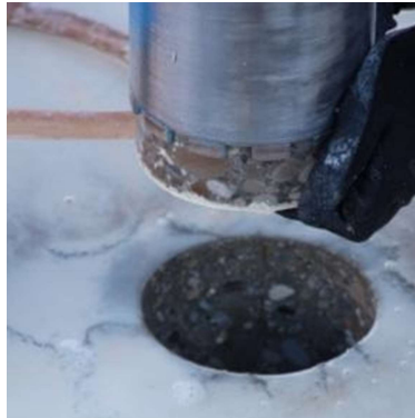
Entnahme von n = 7 Bohrkernen nach rd. 14 d
