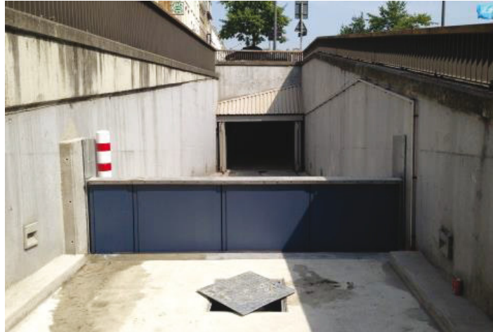
Abbildung 8: Fertiggestellte Barriere in der Ausfahrtsstraße des Parkplatzes [2]
