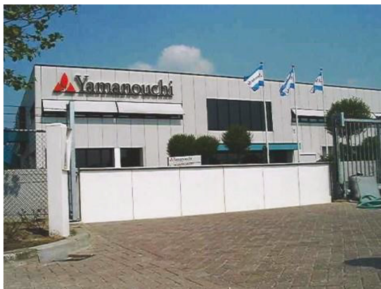
Abbildung 5: Hochwasserbarriere am Zufahrtstor der Firma Yamanouchi [Quelle: http://www.hyflo.nl/Project_En.html , Zugriff am: 18.06.2016]
