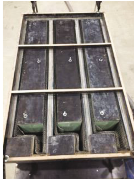
Abbildung 18: Schalung für die Probekörper
