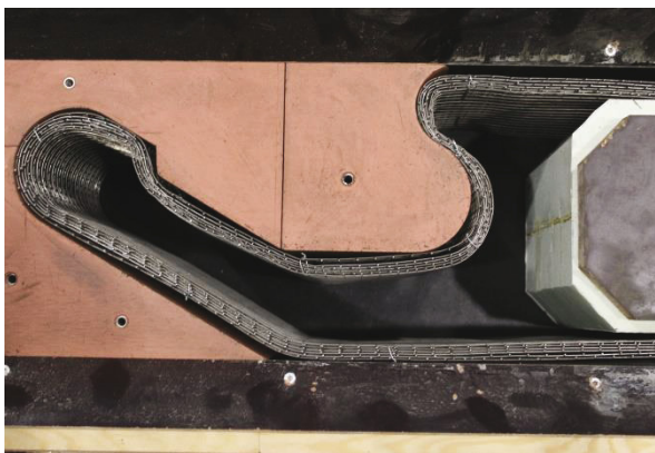
Abbildung 85: Schalung mit Bewehrung
