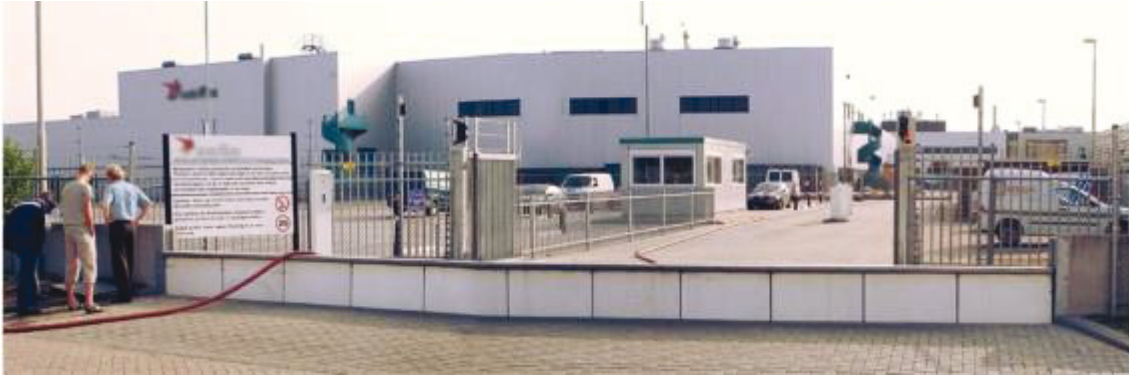
Abbildung 6: Hochwasserbarriere am Zufahrtstor des Unternehmens [1]
