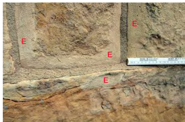
Bild 14: Sandsteinquadermauerwerk mit Verfugung nach vorheriger Restaurierung mit Steinerfüllmörtel („E“)
