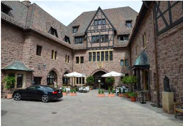
Bild D5.3: Teilansicht des Innenhofs: Die Wandflächen wurden komplett neu verputzt.
