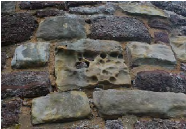
Bild 32: Mauerwerk südliche Wehrmauer der Wartburg vor der Sanierung
