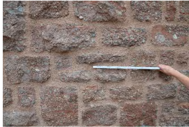
Bild D5.4: Detail einer neu verputzten Wandfläche ohne sichtbare Schädigung der Verfugung nach drei Jahren Standzeit
