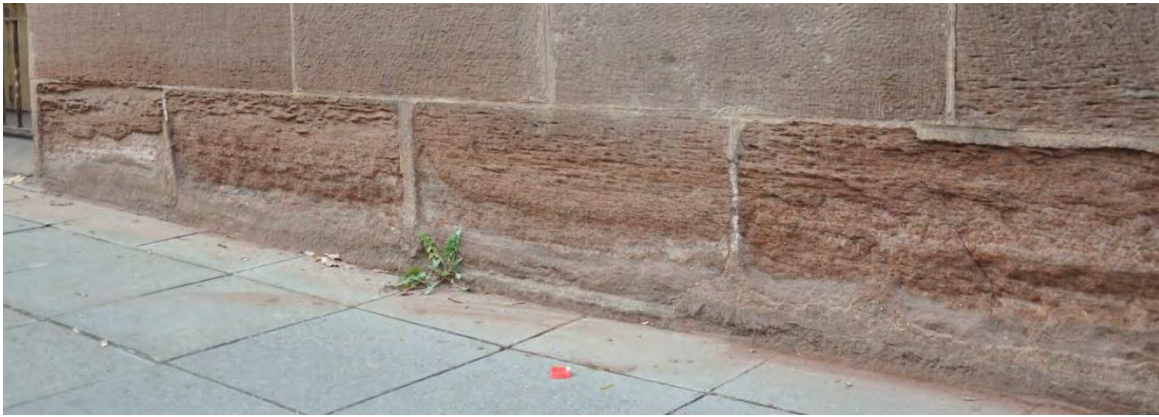
Abb. F6: Sockelbereich Südost-Seite Egle-Bau der HFT in Stuttgart
