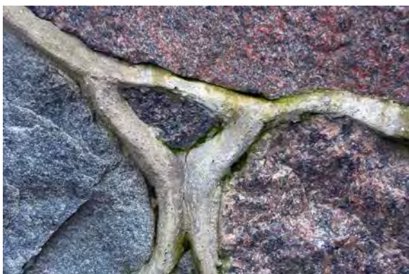
Bild 13: Bruchsteinmauerwerk aus gespaltenen Findlingen mit „erhaben“ aufgeführter Verfugung
