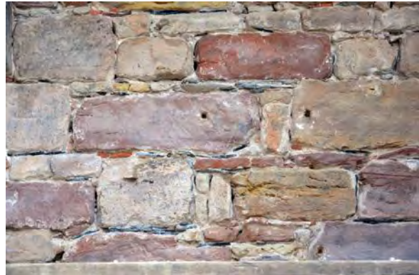
Bild 8: Ehemals verputztes Bruchsteinmauerwerk aus Sandsteinquadern mit Flusskieseln, Schieferstücken und Dachziegelbruch als Zwickelmaterial in den Fugenbereichen
