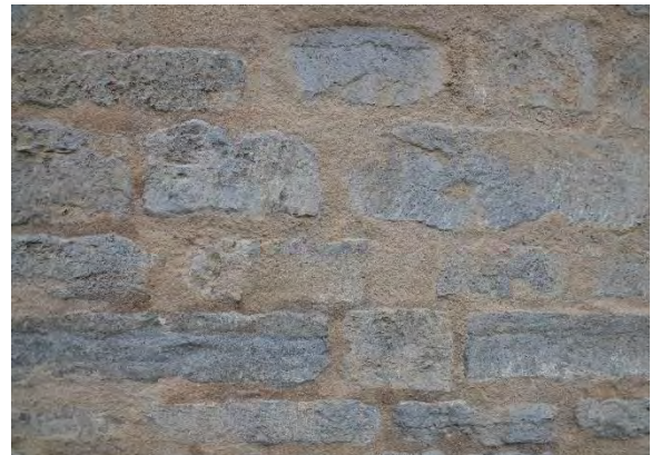
Bild D1.5: Detail der Neuverfugung im Trockenspritzverfahren aus dem Jahre 2011 nach 3 Jahren Standzeit
