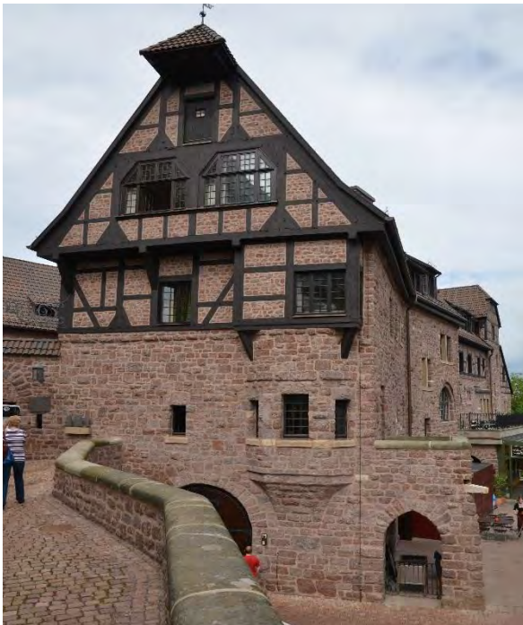
Bild D5.5: Wartburghotel - Giebelansicht Süd: Die Wandflächen wurden 2011 komplett neu verputzt.
