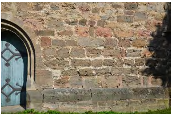
Bild 3: Schichtmauerwerk aus mit Kalkmörtel versetzten Sandsteinen und Gipsmörtelverfugung
