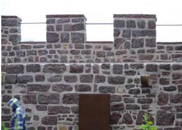
Bild 34: Teil der südlichen Wehrmauer nach der Sanierung
