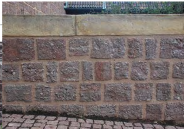
Bild 35: Mauer neben der Dirnitz nach der Sanierung
