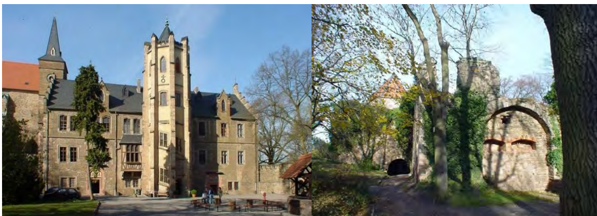
Bild D1.2: Ansicht Hauptschlusses mit Treppenturm
