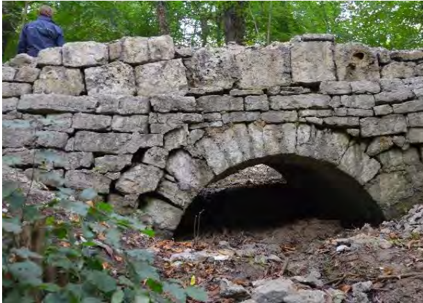
Bild D6.1: Teilansicht der Natursteinbrücke vor der Sanierung. Die Altverfugung wurde bereits entfernt.
