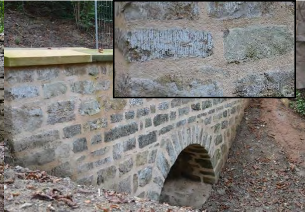
Bild D6.2: Teilansicht nach der Neuverfugung (Handverfugung) mit auf den Bestand abgestimmtem Mörtel.
