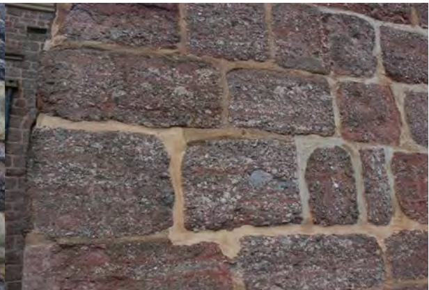
Bild 33: Nordseite der Dirnitz auf der Wartburg mit alten Fugenausbesserungen
