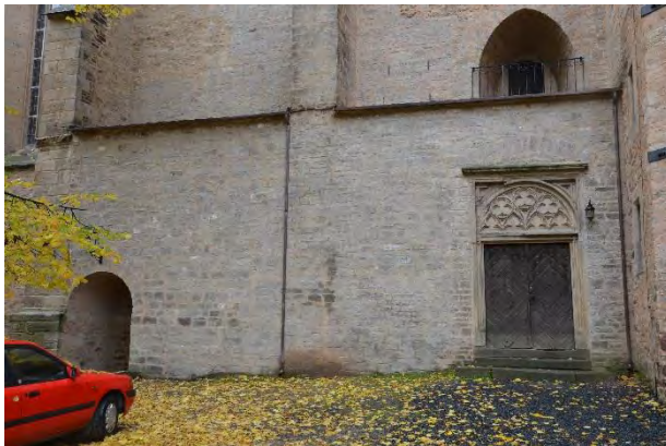
Bild D1.4: Wandbereich an der Schlosskirche mit Neuverfugung, Feuchteschäden sind im Sockelbereich partiell erkennbar
