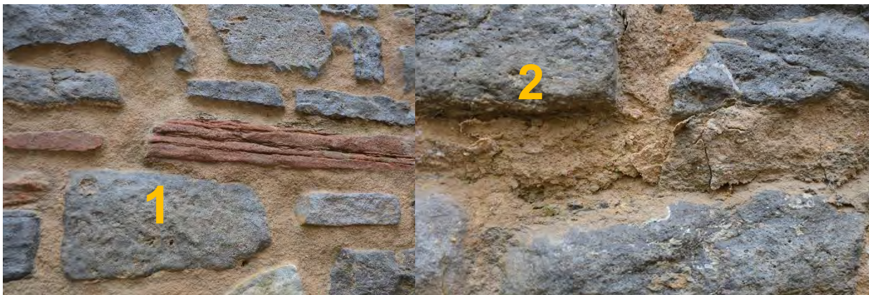
Bild D1.9: Wand an der Ruine Mittelort mit Verfugung nach 2 Jahren Standzeit
