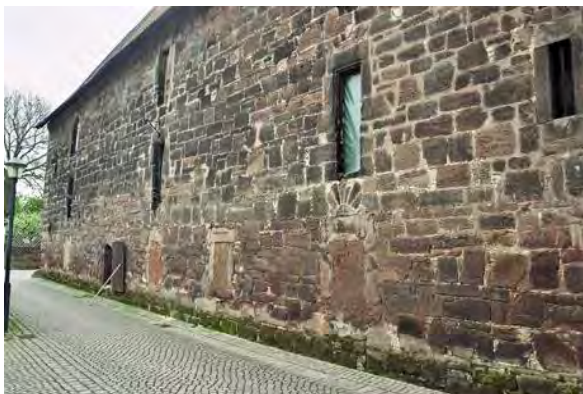
Bild 27: Straßenpflaster im direkten Kontakt zum Quadermauerwerk
