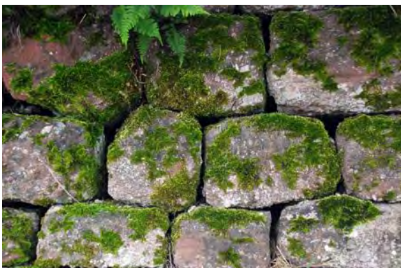
Bild 9: Quadermauerwerk aus Wartburgkonglomerat als Trockenmauerwerk
