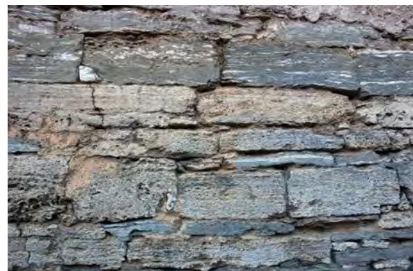
Bild 4: Schichtenmauerwerk einer Stadtmauer mit sehr hohem Gipssteinanteil
