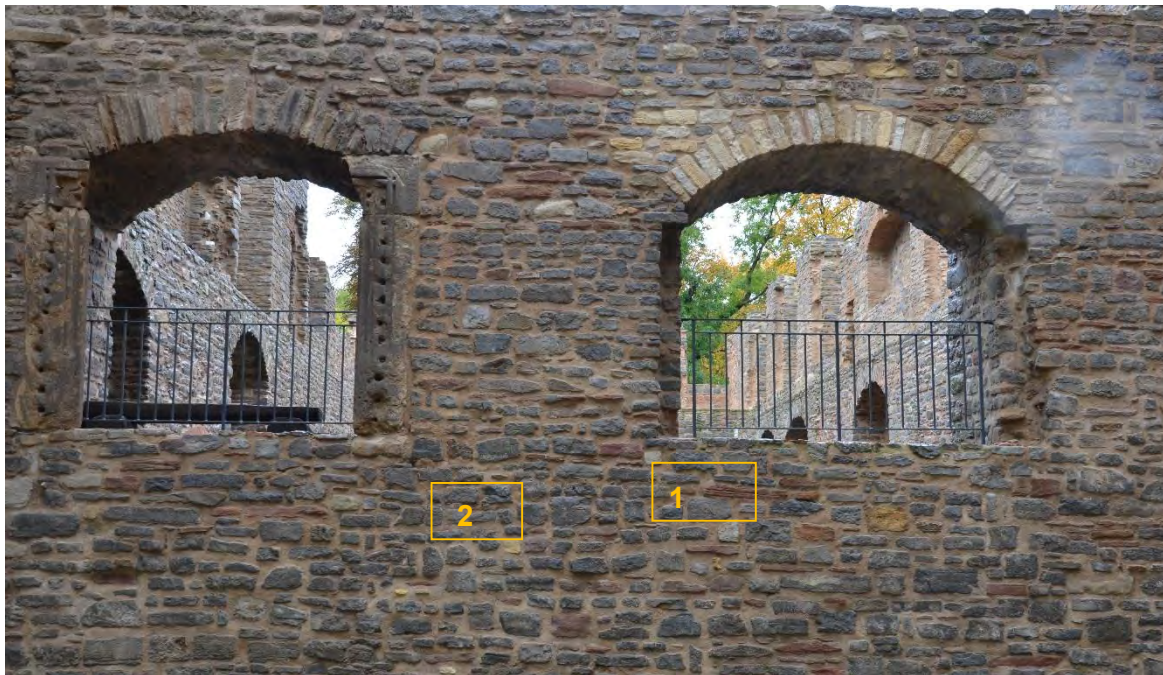
Bild D1.9: Wand an der Ruine Mittelort mit Verfugung nach 2 Jahren Standzeit
