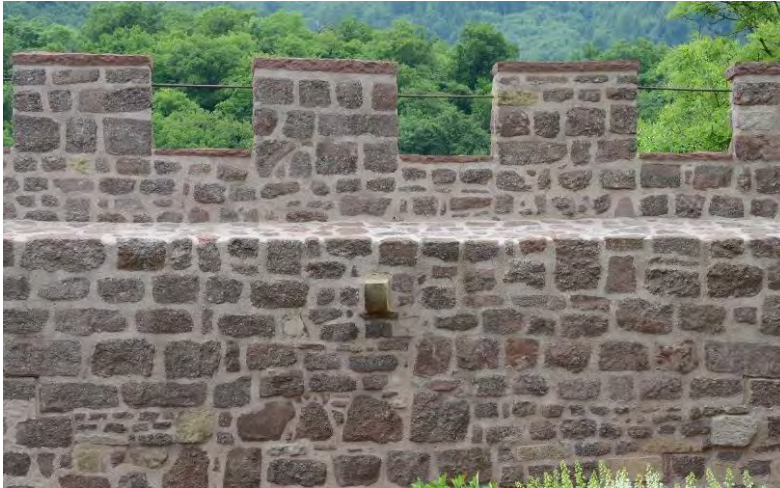
Bild D5.13: Teilansicht der Wandflächen der Nordseite der südlichen Wehrmauer mittlerer Bereich: Die Verfugung wurde ausgehend von den Fugen leicht auf den auf den Stein gezogen.
