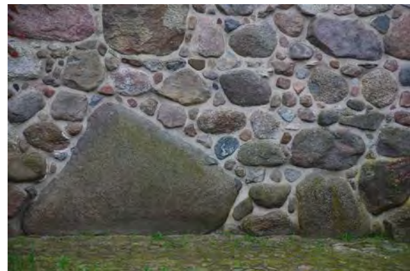
Bild 2: Historisches Feldsteinmauerwerk mit neuer, tief hinter den Steinoberflächen zurückliegender Verfugung
