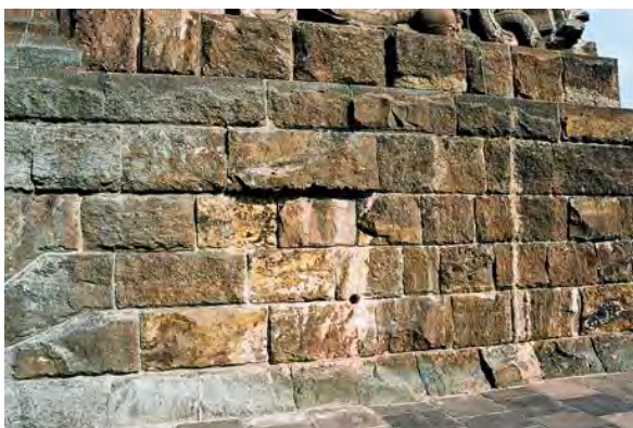
Bild 23: Quadermauerwerk aus Kyffhäuser-Sandstein mit tief zurückliegenden Fugen
