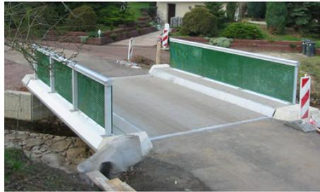
Abbildung 3.16.: GFK-Brücke Klipphausen Sachsen - [[www.baulinks.de/webplugin/2004/i/1711-gfk2.jpg](http://www.baulinks.de/webplugin/2004/i/1711-gfk2.jpg)]
