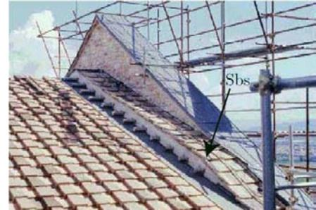
Abbildung 2.24.: Formgedächtnislegierungs-Dämpfer für erdbebenertüchtigte Verbindung zwischen Haupttragwerk und Tympanon der Basilika San Francesco in Assisi [JCMR05]
