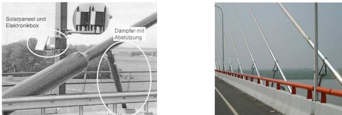
Abbildung 2.19.: MR-Dämpfer auf Eiland-Brücke mit Stromversorgung (links) [WDN05] / Dongting Lake Bridge China mit MR-Dämpfern (rechts) [DNK05]
