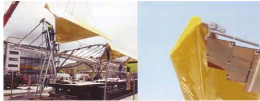
Abbildung 3.19.: Busbahnhof Emsdetten ox2-Architekten - Aufbau und Detail, nach Gregor Brune in [FOM04]
