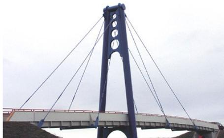
Abbildung 3.15.: GFK-Brücke Schwerin - [[de.structurae.de/photos/index.cfm?JS=25742](http://de.structurae.de/photos/index.cfm?JS=25742)]
