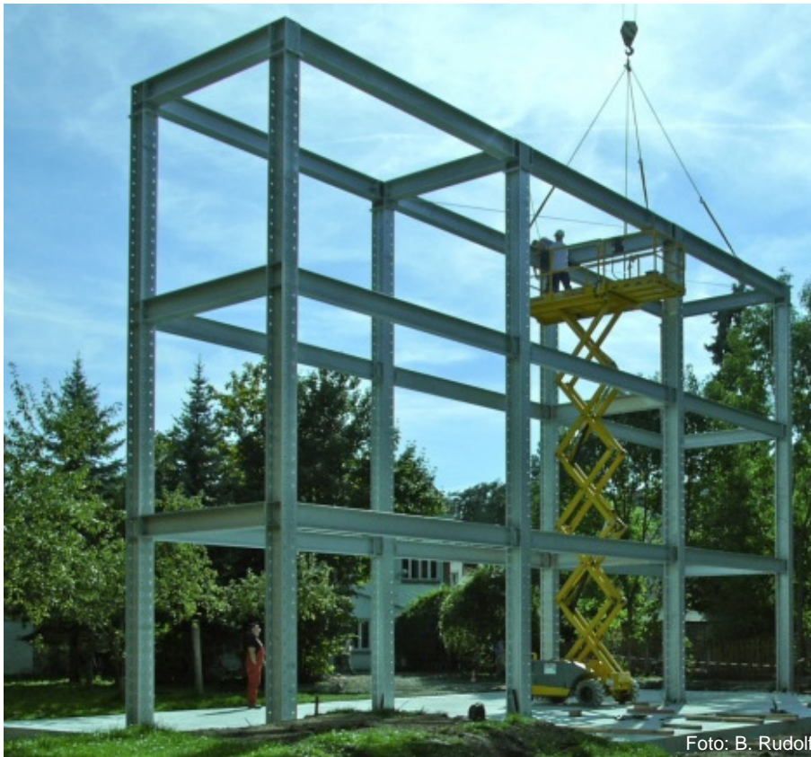
Abb. 7-1 Stahlskelett des Experimentalbaus X.STAHL
