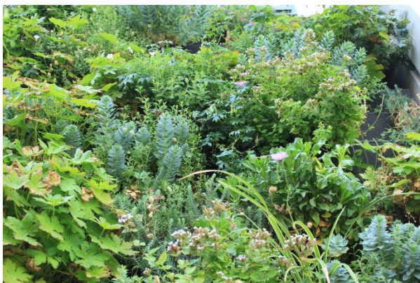
Abb. 3.5: Modulare WB aus Kunststoff an einem Gebäude in Frankreich.
