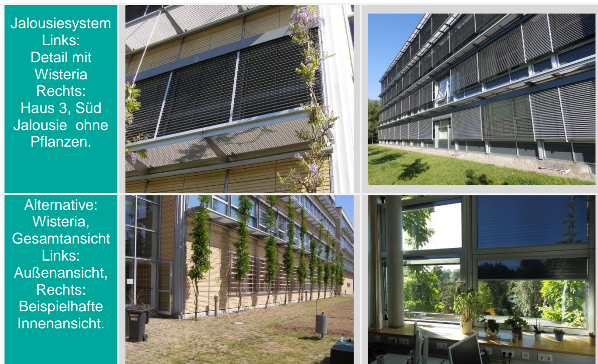
Abb. 5.5: Beispiel für technisches Jalousiesystem zur Verschattung sowie Wisteria als Alternative (Hochschule Neubrandenburg).
