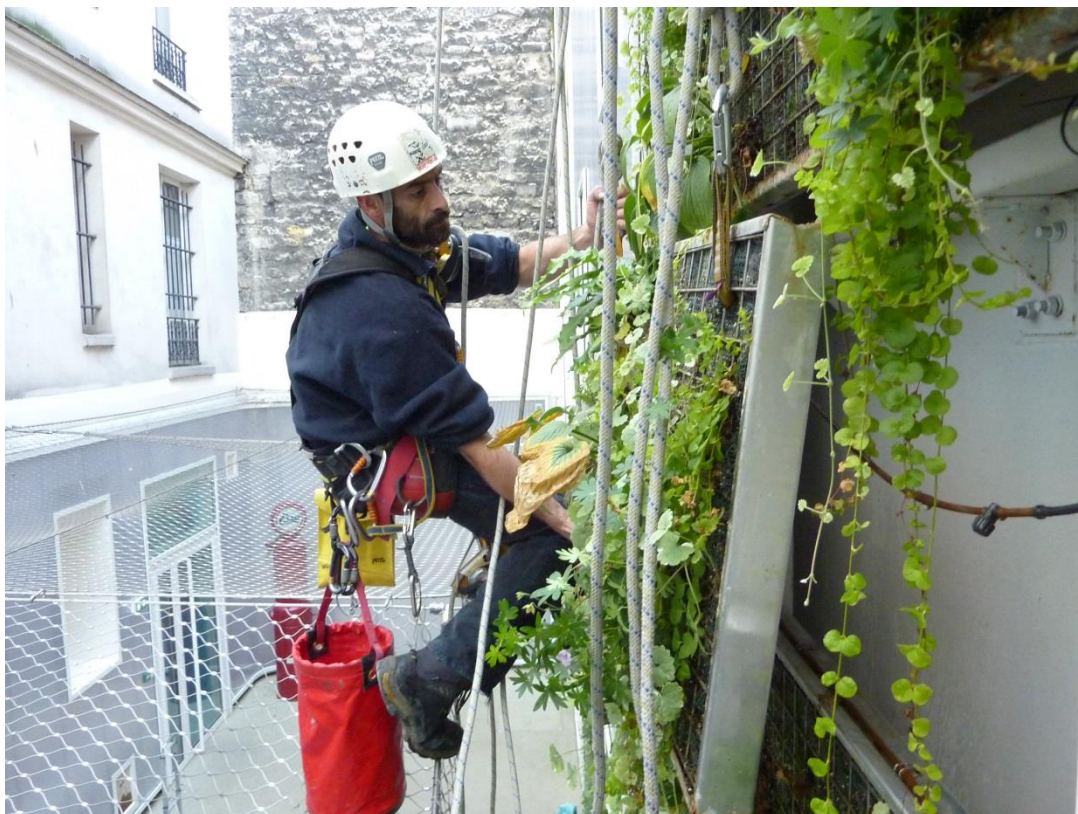
Abb. 5.3: Gerüstkletterer bei der Installation einer Wandbegrünung in Paris (Oktober, 2013, Foto von F.Lassalle,Vivagreen).
