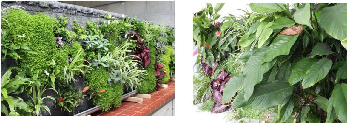
Abb. 3.31: WB Geovlies-Eigenbau - Innenraum – Wandmodul (links Mai 2012, rechts August 2014).
